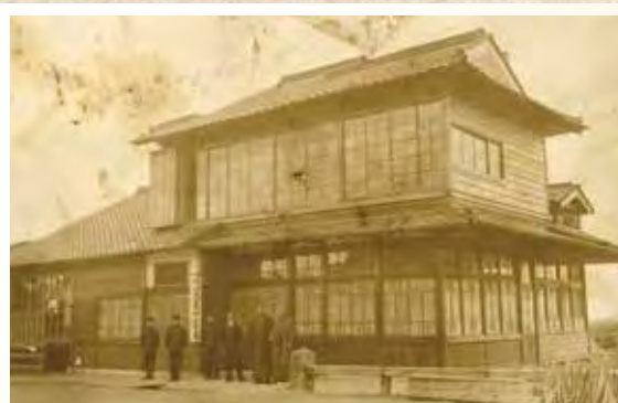
▲昭和38年当時の出水駅(写真提供:出水市歴史民俗資料館)
