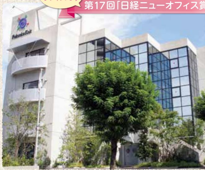
▲4階建の本社ビル。近代的な空間に先進的な機能を備える
