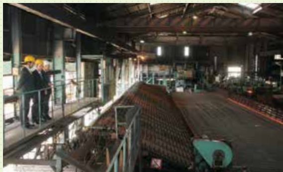
▲鉄筋製造ライン
