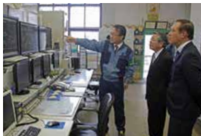
▲水力発電所遠隔監視制御システム
