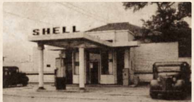
▲昭和6年にオープンした新出光のサービスステーション第1号店「連池給油所」。当時、ハイカラなデザインの建物として注目された
