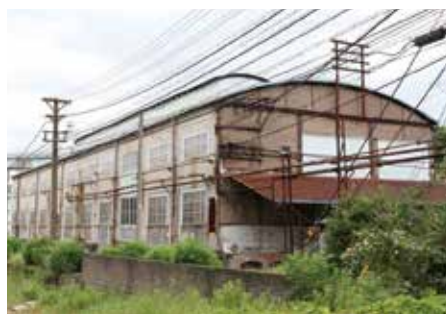
旧鍛冶工場 (新日鐵住金株式会社 八幡製鐵所 所蔵)
