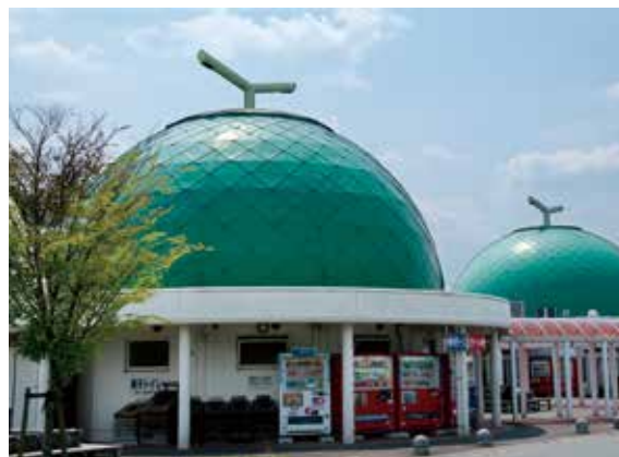
道の駅『七城メロンドーム』
