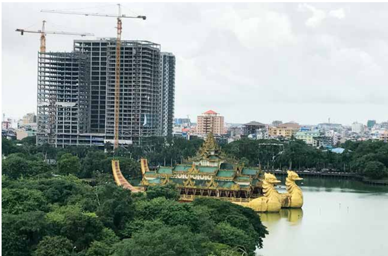
外国資本参画による不動産建設もラッシュ
