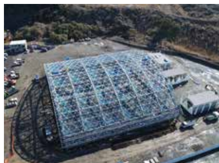
現在建設中の多目的屋内施設
