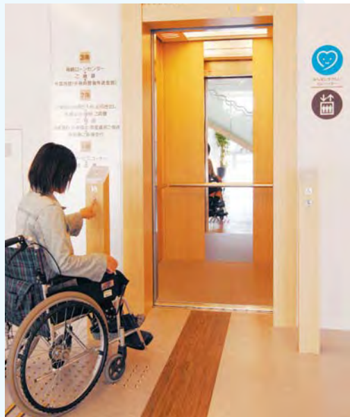
車椅子を寄せやすいように、エレベーターのスイッチは一段前に張り出した場所に設置しました。また、エレベーター内の鏡で、車椅子の後ろも見えやすくなっています。
