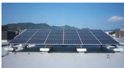
太陽光発電の設置
