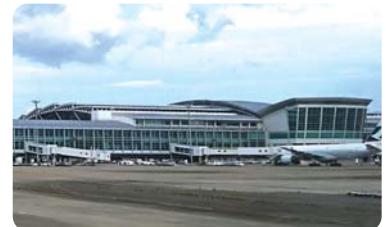
空港・高速道路・鉄道整備
