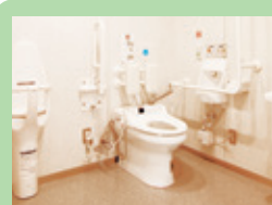
多目的トイレの設置
