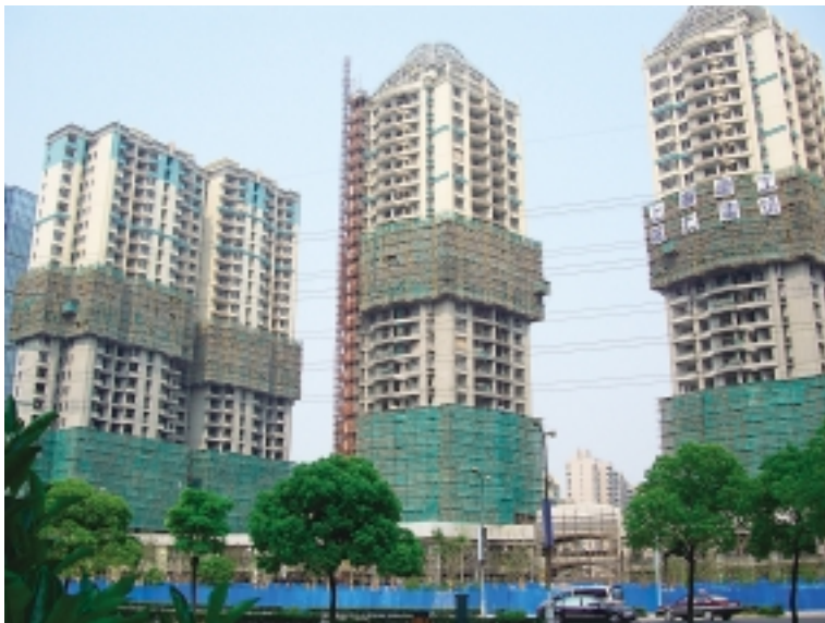
建設中のマンション群(日本人が多く居住する地区)
