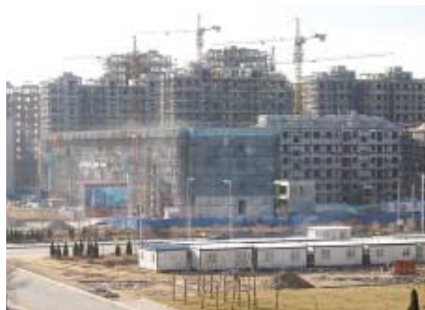
建設中の花園口経済区内風景
