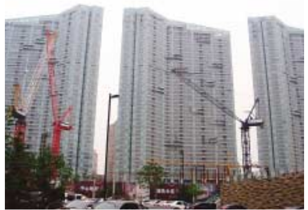
建設が進む高層マンション群
