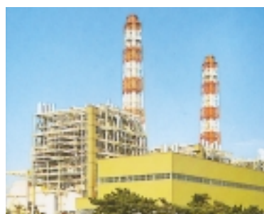
当社が関わった火力発電プラント
