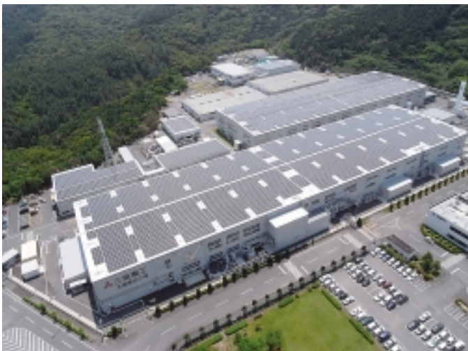
三菱重工諫早太陽電池工場の屋根に設置された太陽電池(500KW・800KW)
